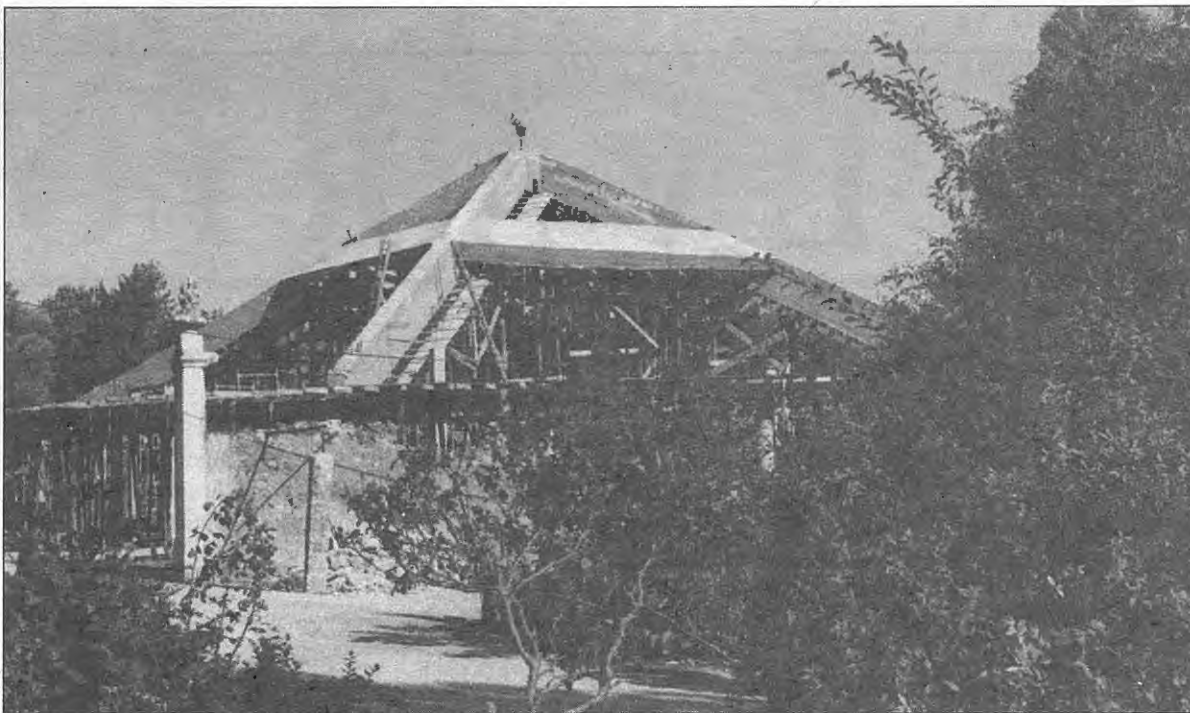
Resolvidos os problemas estruturais, vamos dar início aos acabamentos da Capela.
